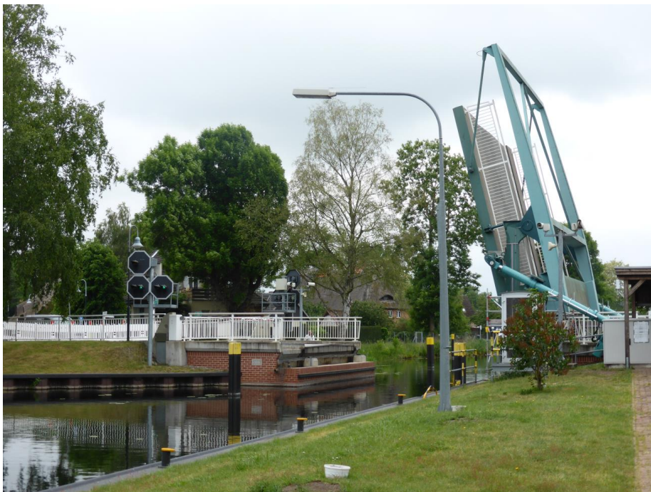
Die geöffnete Klappbrücke in Banzkow Urheber der Bildquelle: WSA Lauenburg, 2020
